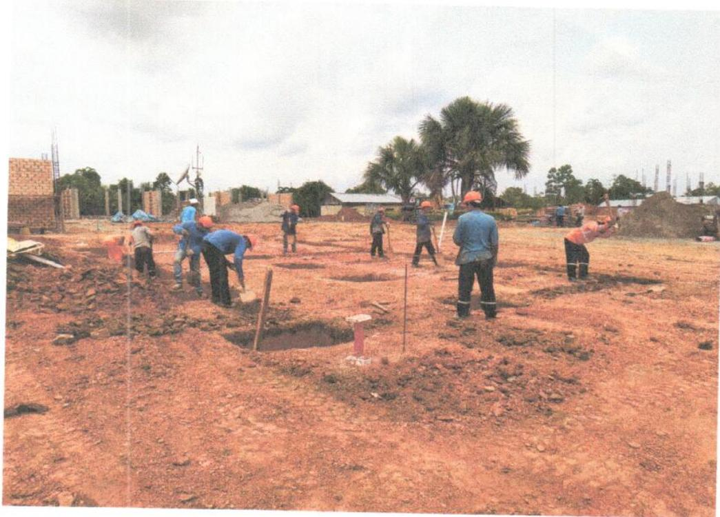
Foto N° 13: Vista de las excavaciones de zanjas de zapatas en el módulo "E" en la obra "Mejoramiento y Equipamiento del servicio Educativo N 62200 Barrio Carabanchel - San Lorenzo, Distrito Barranca, Provincia Datem Del Marañón - Loreto"
