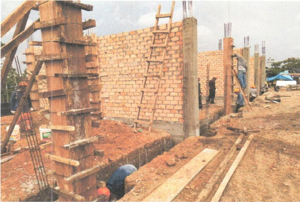
Foto N° 03: Vista del Encofrado y encofrado de columnas en el módulo "F" en la obra "Mejoramiento y Equipamiento del servicio Educativo N 62200 Barrio Carabanchel - San Lorenzo, Distrito Barranca, Provincia Datem Del Marañón - Loreto"
